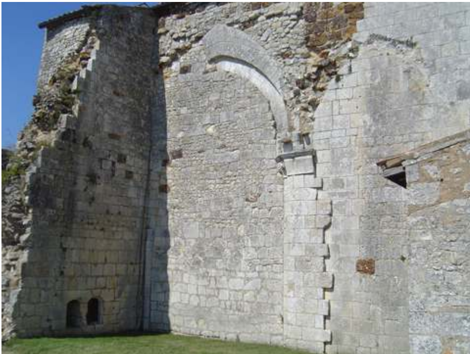
Fig. 8 – Photographie de l'élévation sud de l'église abbatiale de Pleine-Selve : on peut observer les vestiges du transept et les traces des travaux pour réaliser une chapelle (cl. Juliette Masson, 2008).
